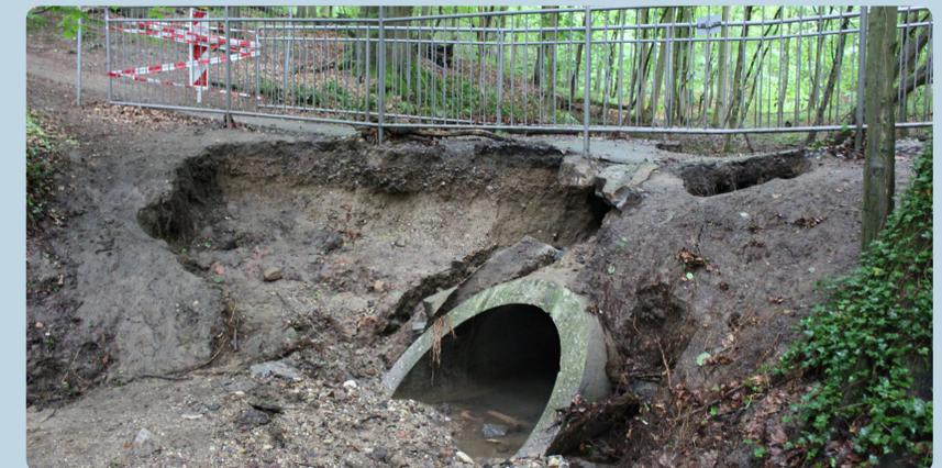
Durch Starkregen zerstörter Durchlass
